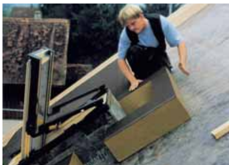
Obr. 34 Strecha s tuhou tepelnou izoláciou nad hornou úrovňou krokiev
