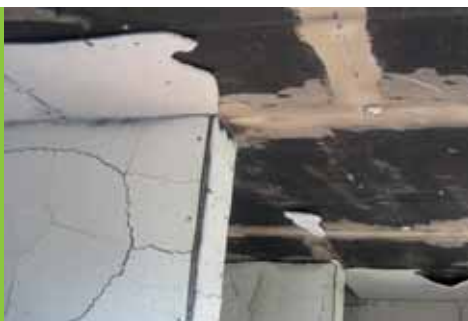
Obr. 29 Poškodená bola iba prvá vrstva sadrokartónu
