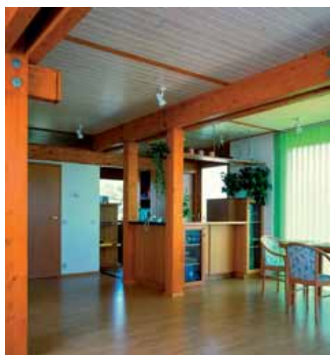
Obr.14 Interiér drevostavby so skeletovou konštrukciou
