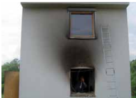
Obr. 27 Po ukončení skúšky zostal objekt zvonka nepoškodený
