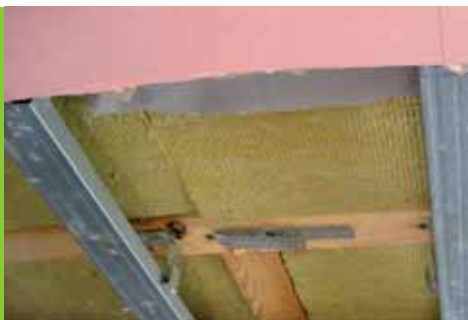
Obr. 30 Nepoškodené časti po odstránení vrstiev
