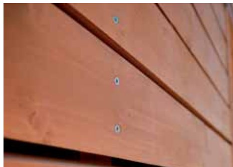
Obr. 31 Prevetrávaná fasáda s dreveným obkladom
