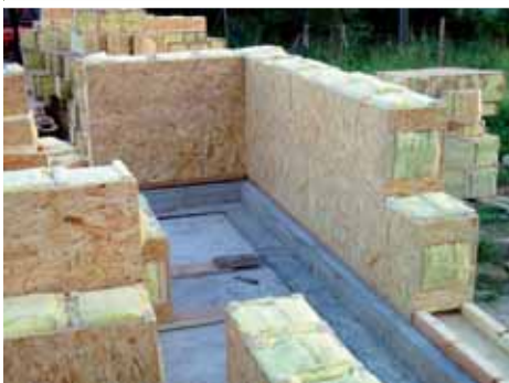
Obr. 38 Konštrukčný systém z modulov na báze OSB – dosky vyplnený minerálnou vlnou
