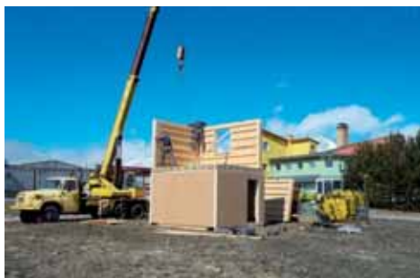
Obr. 25 Montáž demonštračného objektu
