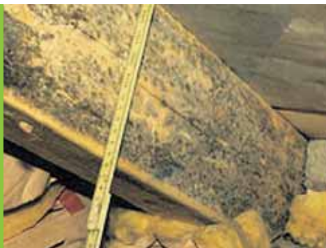
Obr. 32 Poškodenie krokví plesňou a hnilobou kvôli prieniku vodnej pary do konštrukcie
