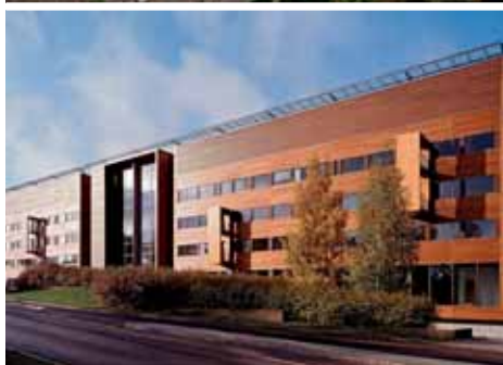
Obr. 22 Drevená prefabrikovaná administratívna budova Finforest Modular Office vo fínskej Tapiole
