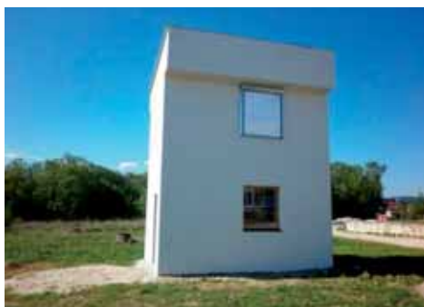
Obr. 26 Objekt pripravený na skúšku
