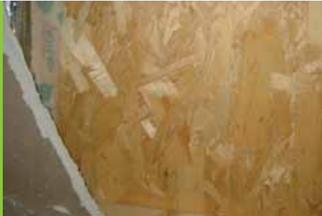
Obr. 28 Nepoškodená OSB doska pod inštalačnou vrstvou vytvorenou izoláciou ISOVER Ultimate
